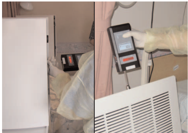
Ein leitender Techniker des EMSD prüft die tatsächliche Filtereffizienz von zwei Luftreinigern mit einem Laser-Partikelzähler. Ein Großteil der konventionellen Luftreiniger konnte den Test nicht bestehen.
